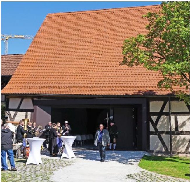
Die Zehntscheune ist feierlich eingeweiht worden. Doch ein weiterer Sanierungsabschnitt fehlt noch.
