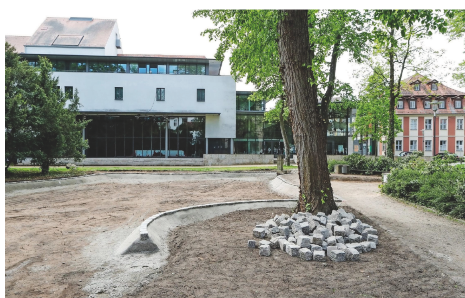
Die Vorarbeiten sind im Gange: Der Harmoniegarten (im Hintergrund das E.T.A.-Hoffmann-Theater) bekommt einen neuen Spielplatz. Foto: M. Hoch
